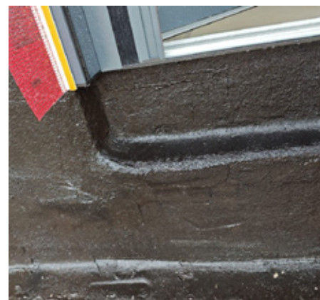
Debeloslojni bitumenski premazi so dobra rešitev, saj je izvedba mogoča tudi pri manj ravnih površinah.
