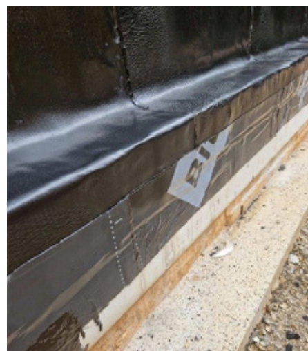
Končan stik preplepljen s LT Elothene 3000X v širini cca 30 cm. Ker je bil stik v talni vodi je dodatno zavarovan z STT Taurus BLACK, ki ima odličen oprijem na vse komponente sistema.
