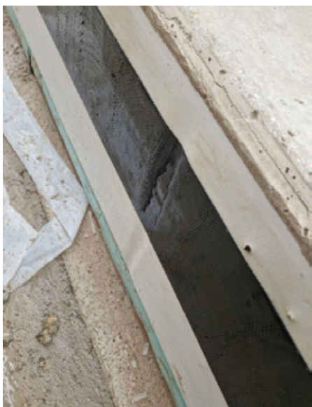
LT Bu-tylene Duo R BT se polno zalepi na rob talne plošče
