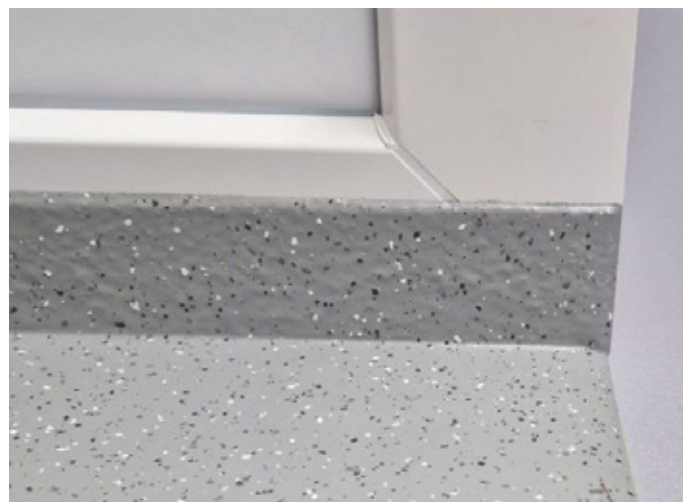
Detajl zaključka na okviru vrat
