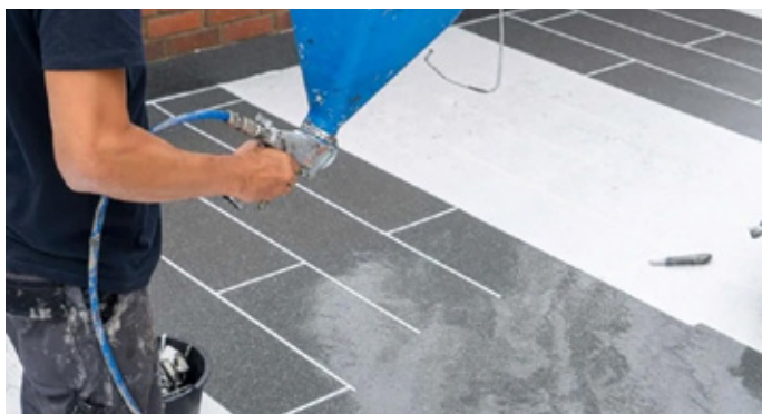
Posipanje s chips-om 50 g/m 2 za doseganje protidrsnosti razreda R10
