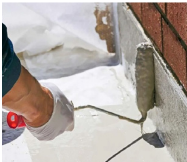
Izvedba hidroizolacije Wecryl 230 THIX na vertikali
