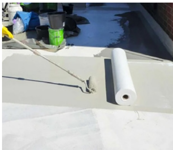
Izvedba hidroizolacije Wecryl 230 na horizontali
