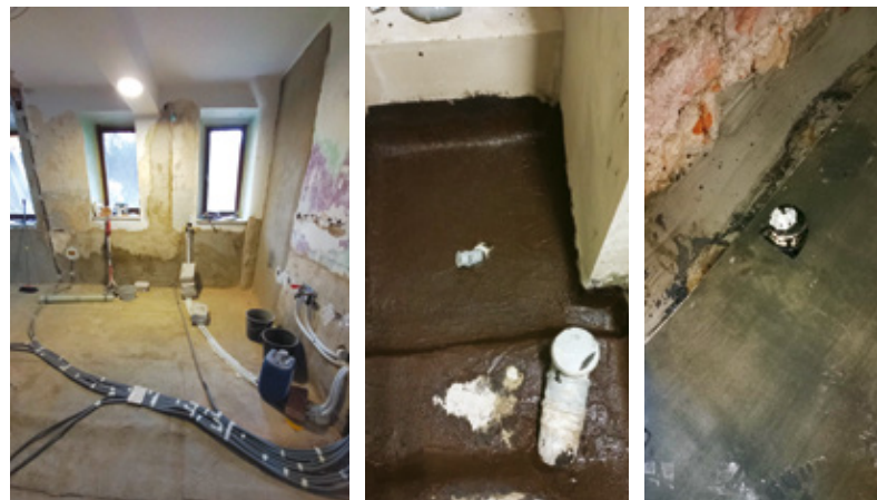
Primer uspešne sanacije kletnega stanovanja s preseženimi vrednostmi Radona z bitumenskim trakom z ALU vložkom in detajli narejeni z LT Bitublock 2K.
