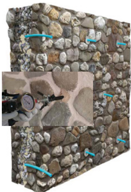
Slika 5: Injektiranje votlin v obstoječi zidani steni z NHL 3.5 malto Legante per iniezioni 790.
