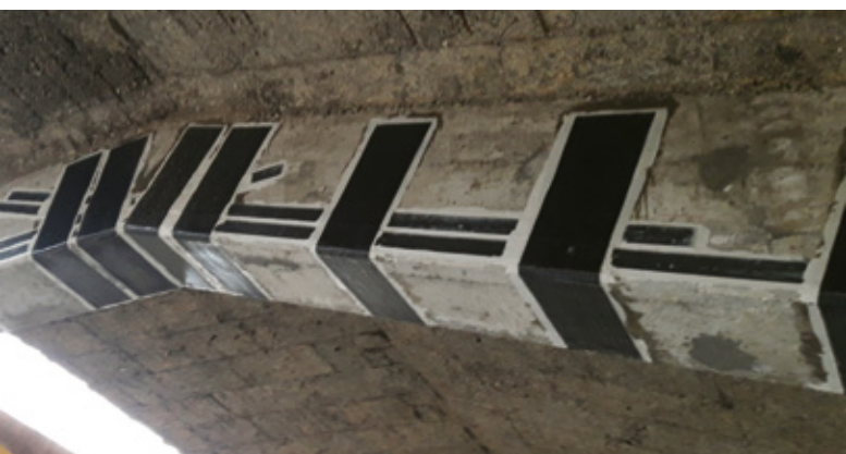
Slika 3: Primer ojačitve betonskega nosilca s »karbonsko armaturo«. Za lepljenje lamel se uporablja drugačna epoksi malta kot za tkanino.
