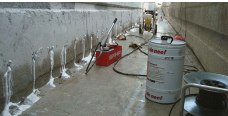
Slika 8: Primer injektiranja stika temeljne AB plošče stene izvedene po sistemu »bele kadi«
