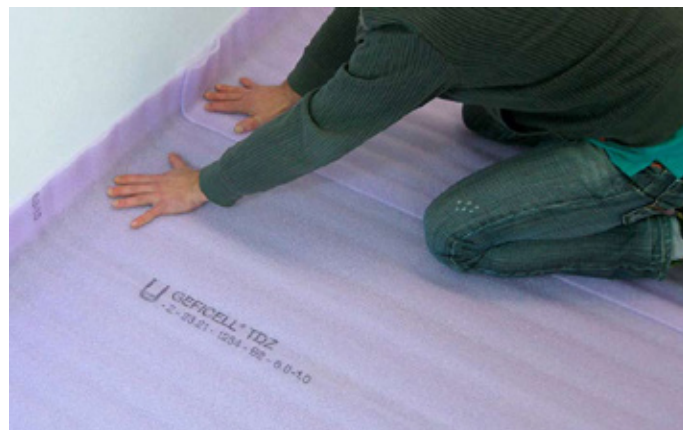
Slika 2: Polaganje akustične podloga Geficel TDZ
