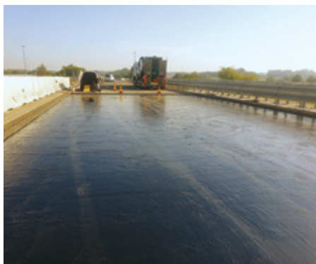
Strojna vgradnja asfalta
