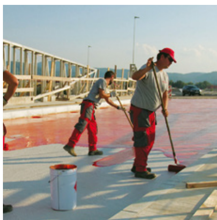
Nanos sloja Bond Coat 3 za sprijem z asfaltom (le za ceste)
