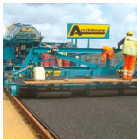
Nanešen sloj Bond Coat SA 1030 za sprijem z asfaltom v primeru zahtevnih pogojev
