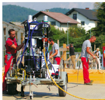
Eliminator se vgrajuje z 2 komponento brizgalno črpalko z razmerjem 1:1 brez segrevanja
