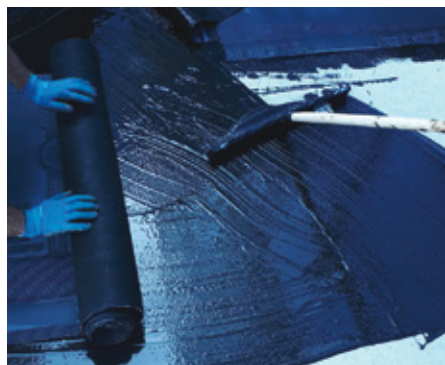
Nanos mase in vgradnja prvega sloja bitumenske hidroizolacije Isorooft v svežo maso
