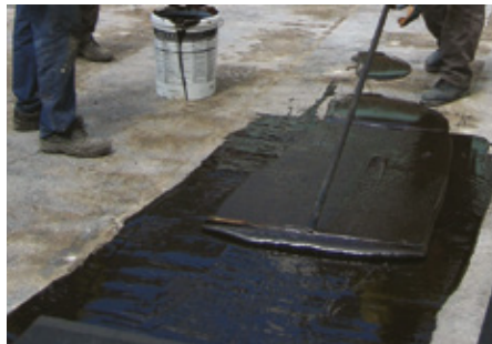
Nanos Servidek mase na betonsko površino
