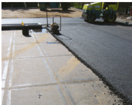
Hydroizolacija parkirne ploščadi Servidek/Servipak z direktno vgradnjo asfalta
