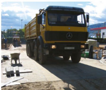
Servidek/Servipak je povozen za gradbeni promet že 4 ure po vgradnji
