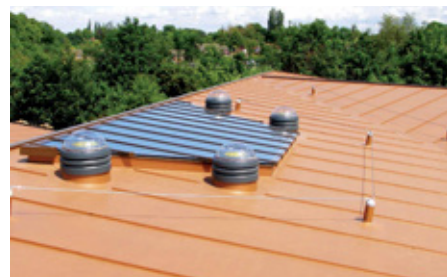
Streha izvedena po sistemu AlkorMetallics
