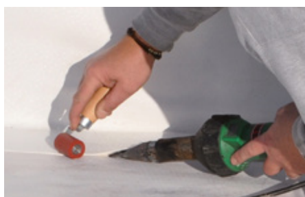
Varjenje stikov z vročim zrakom brez uporabe plamena
