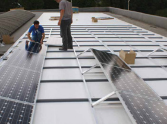
Vgradnja AlkorBright membrane v kombinaciji z Alkorsolar profili za pritrdjevanje solarnih panelov brez vrtanja skozi membrano.
