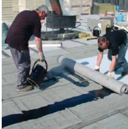
Vgradnja Alkortece folije z vročim bitumnom
