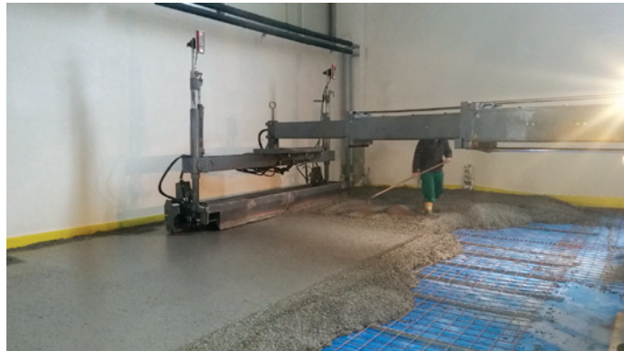
Vgradnja industrijskega tlaka na folijo Gefitas
