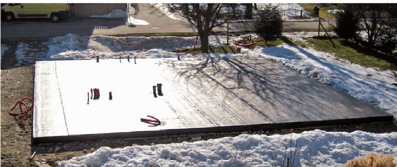
Bitumenska hidroizolacija na plošči
