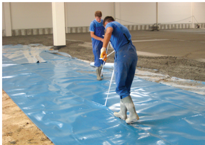
Lepljenje slojev med dvema rolama folije Gefitas
