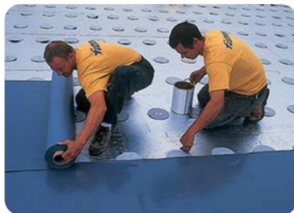
Postavljanje in razvaljanje membrane
