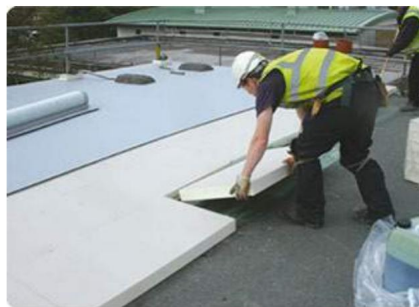
Namestitev izolacijskih plošč
