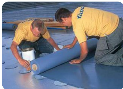
Nanašanje lepila FF855 na pritržilne plošče FF852
