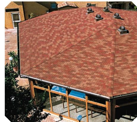
**Top Shingle in Eco Roof sta namenjena pretežno za pokrivanje vrtnih ut in nadstreškov. Za pokrivanje gradbenih objektov-stavb priporočamo tipe Master in Premium.**
