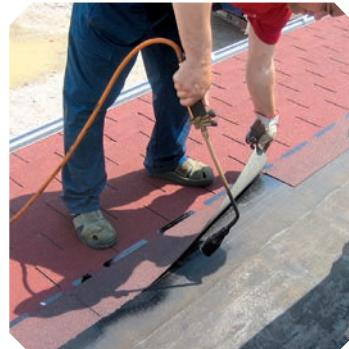
Vgradnja Tegole Canadese na bitumenski trak se izvaja po vročem postopku.
