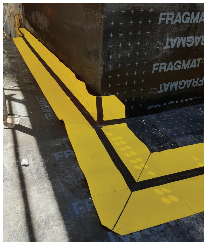
Pripravljena dilatacija za vgradnjo
