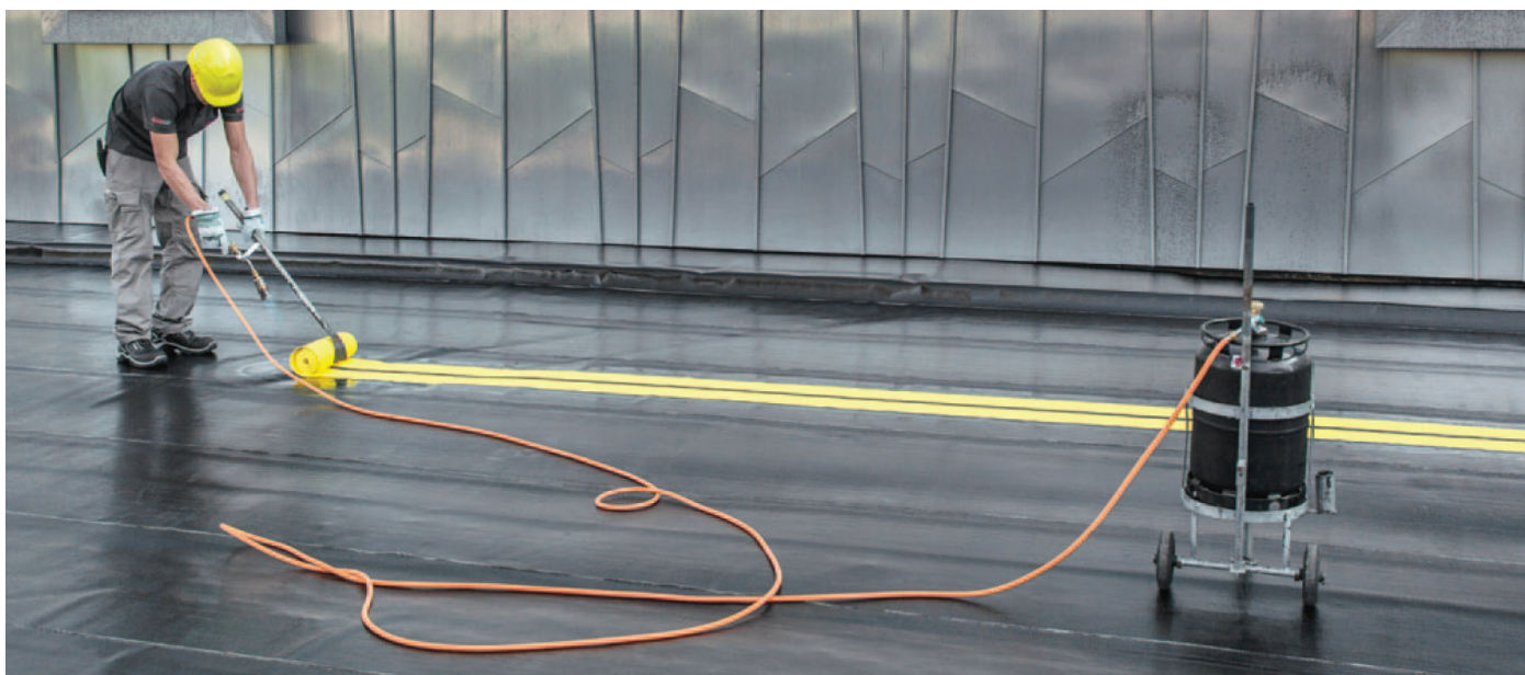
Vgradnja dilatacije v prvi sloj hidroizolacije.
