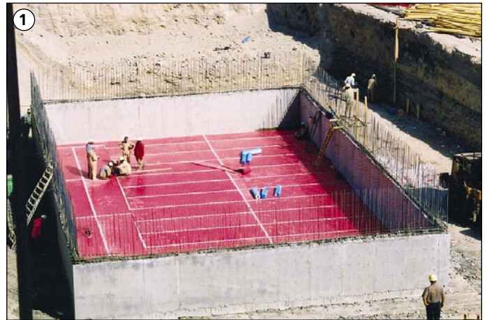
Protivibracijska izolacija stavbe (v bližini železnice)
