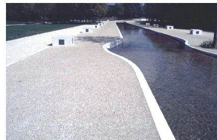
Končni izgled pohodne betonske površine pri uporabi proizvoda VBA Bio
