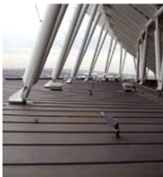
Streha stadiona, prekrita s Flagon EP-PV F 1,5 mm Ral 7012 - lepljen sistem s lepilom Flexocol A89
