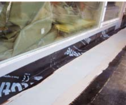
Izvedba vertikalnega zaključka na balkonska vrata
