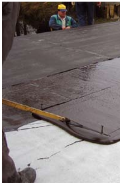
Nanos Servidek mase na betonsko površino in polaganje zaščitnih plošč Servipak v sveži Servidek
