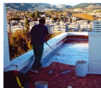
S sintetičnimi folijami lahko ekonomično in kvalitetno pokrijemo praktično vse oblike streh, najprimernejše pa so za velike ravne površine.
