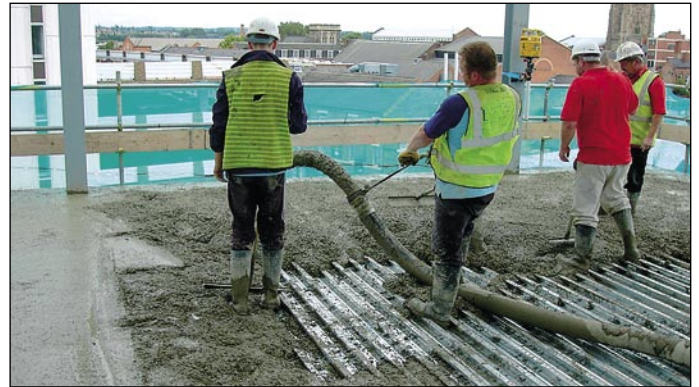
Izvedba medetažne konstrukcije na trapezni pločevini
