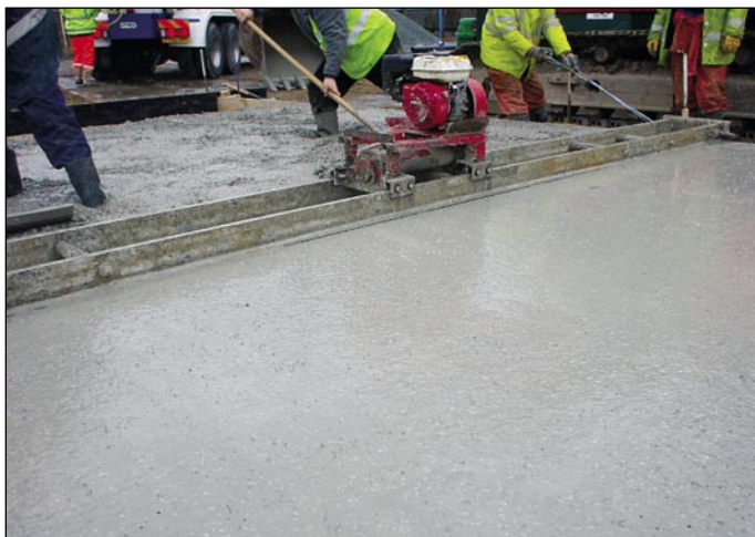
Izvedba industrijskega tlaka s Strux vlakni
