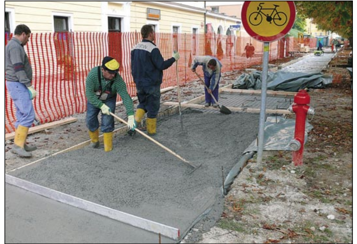
Izvedba zunanjege tlaka
