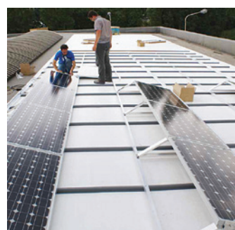
Vgradnja AlkorBright membrane v kombinaciji z Alkorsolar profili za pritrjevanje solarnih panelov brez vrtnja
