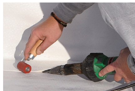
Varjenje stikov s toplim zrakom brez uporabe plamena
