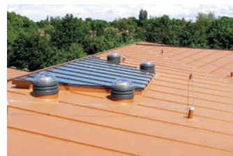
Streha izvedena po sistemu AlkorMetallics
