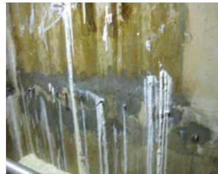
Injektiranje porozne stene
