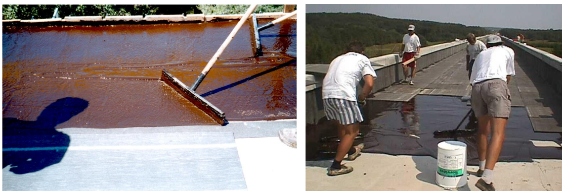
Slika: Enakomerno razporejanje Servidek mase
