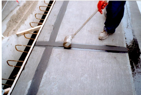
Sliki: Bandažiranje spojev plošč z Armourtape trakom in valjčkanje bandažiranih spojev
