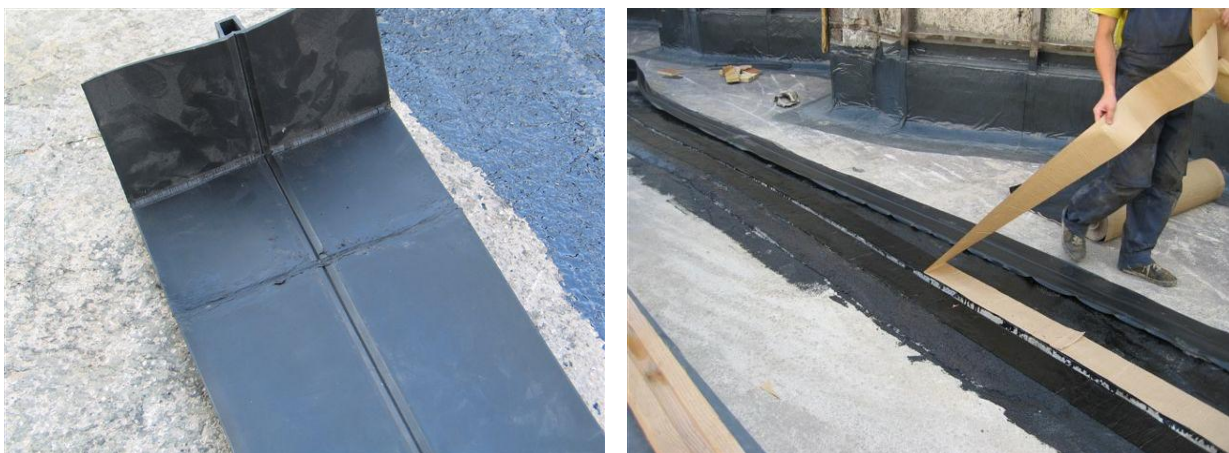
Sliki: Serviseal Type B dilatacijski vložek z tipskim kosom vertikalne in prikaz vgradnje dvostransko lepljivega traku Bitustick 15 cm
