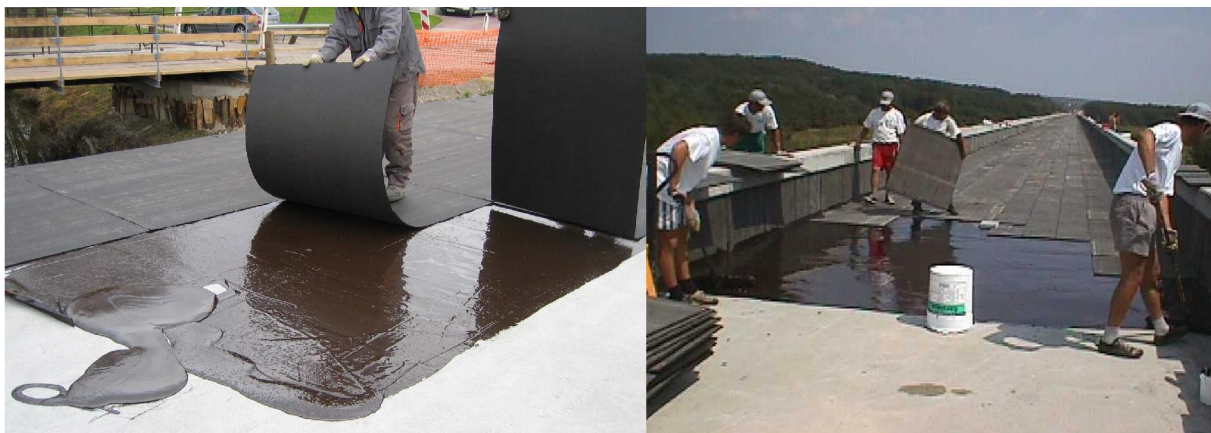
Sliki: Polaganje Servipak zaščitnih plošč debeline 6mm v sveži Servidek in debeline 12mm na železniškem mostu na Slovensko Madžarski meji.
