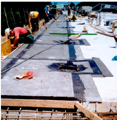
Sliki: prikazujeta uporabo sistema Servidek/Servipak za hodnik mosta in hidroizolacijo prepusta PLOŠČADI
