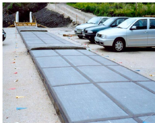
Sliki: prikazujeta uporabo sistema Servidek/Servipak za hodnik mosta in hidroizolacijo prepusta PLOŠČADI
