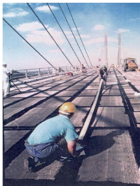
Slike prikazujejo uporabo sistema Servidek Servipak na vozni površini mostu
