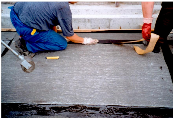
Sliki: Bandažiranje spojev plošč z Armourtape trakom in valjčkanje bandažiranih spojev
