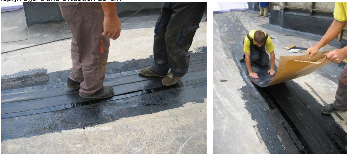
Sliki: Serviseal Type B dilatacijski vložek z tipskim kosom vertikalne in prikaz vgradnje dvostransko lepljivega traku Bitustick 15 cm
