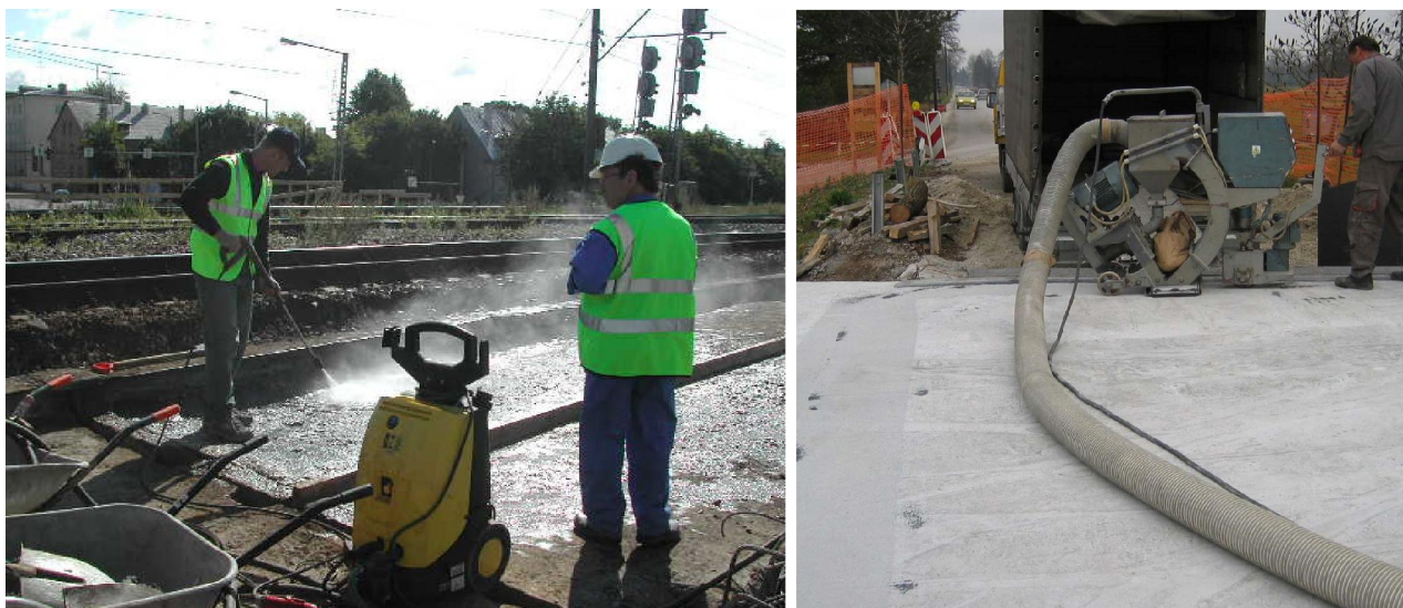
Slika levo: pranje površine železniškega mostu z vodo pod visokim pritiskom Slika desno: odstranjevanje cementnega mleka na vozni površini s peskanjem
