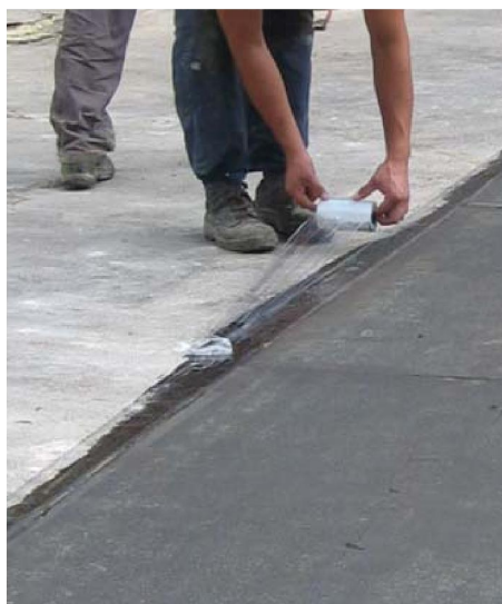
Sliki: predhodno po meri odrezane plošče in označene s številkami ter izvedba zaščite dnevnih stikov s tanko polietilensko folijo
