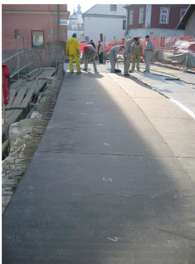
Sliki: predhodno po meri odrezane plošče in označene s številkami ter izvedba zaščite dnevnih stikov s tanko polietilensko folijo
