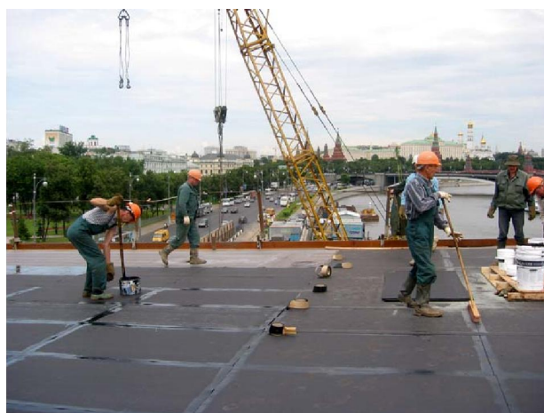
Slike prikazujejo vgradnjo Servidek Servipak sistema na jeklene mostove.
