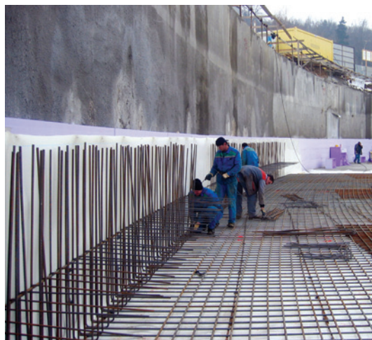
Izolacija Preprufe na kontaktni steni
