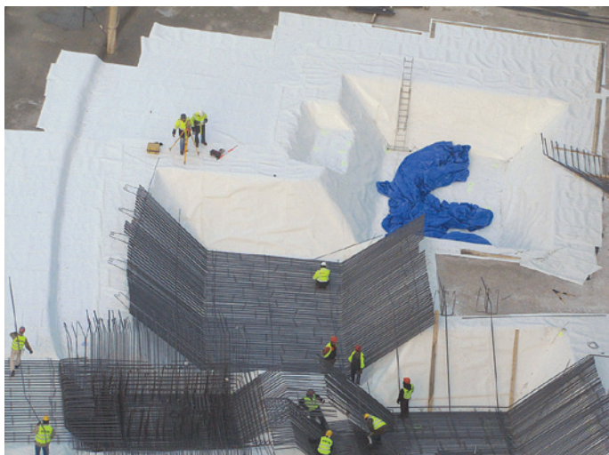
Preprufe vgrajen pod talno ploščo
