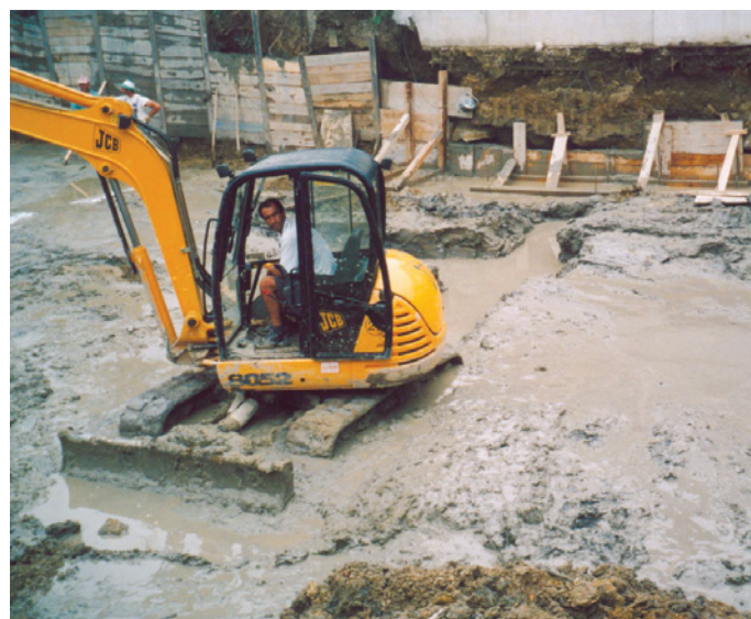
Tipičen primer gradnje na slabo nosilnem terenu v podtalnici
