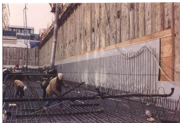
Primeri vgradnje na pilotno steno (permanentni opaž)
