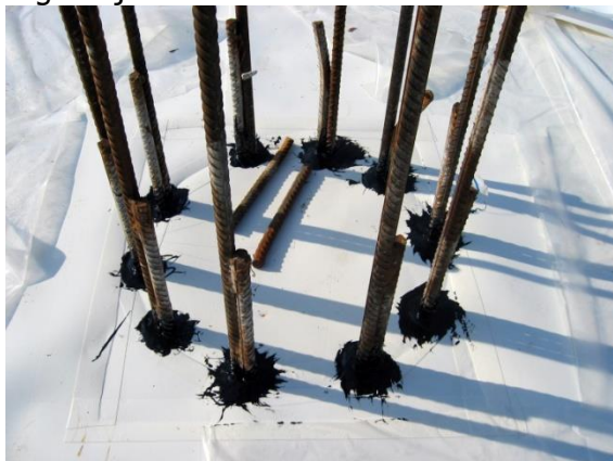
Tesnenje prebojev armature pilota in že vgrajena armatura direktno na Preprufe 300R
