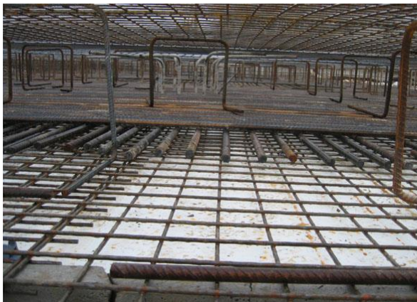
Tesnenje prebojev armature pilota in že vgrajena armatura direktno na Preprufe 300R
