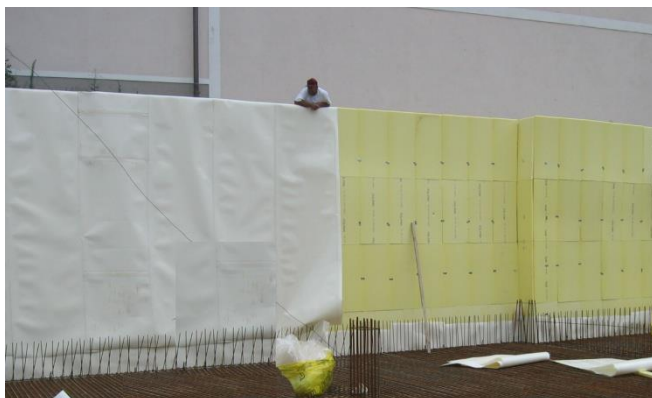
Primeri vgradnje na pilotno steno (permanentni opaž)
