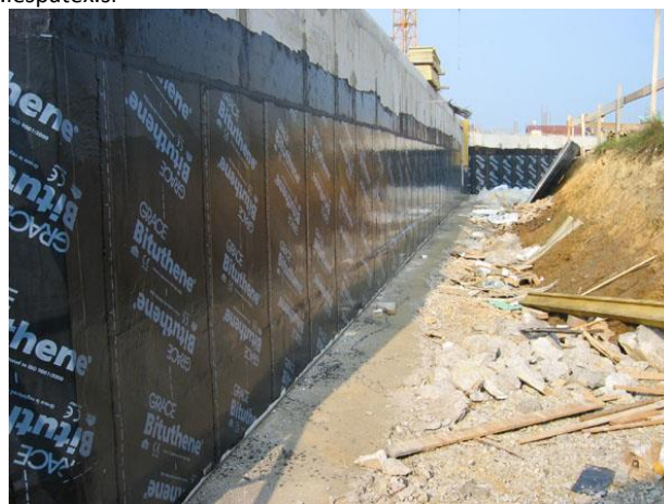
Kombinacija horizontalne hidroizolacije Preprufe 300R in vertikalne hidroizolacije Bituthene
