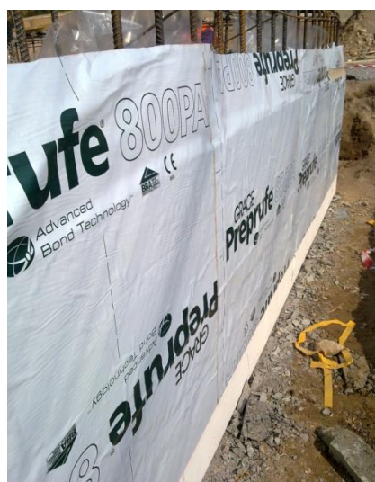
Kombinacija horizontalne hidroizolacije Preprufe 300R in vertikalne hidroizolacije Preprufe 800PA
