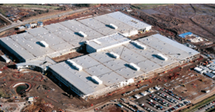
Slika 4: Tipična streha prekrita s PVC membrano Alkorplan F
