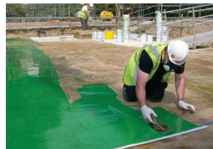
Slika 11: Vgradnja tekoče membrane
