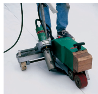
Slika 3: Enostavna vgradnja termoplastičnih membran z varjenjem z vročim zrakom
