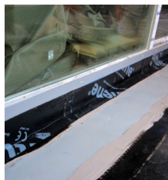
Slika 2: Izvedba vertikalnega zaključka na balkonska vrata
