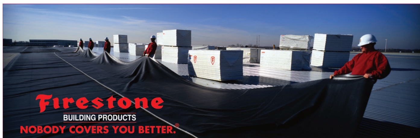
Enostavna vgradnja Ultraply TPO membrane z varjenjem z vročim zrakom
