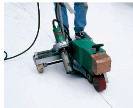
Enostavna vgradnja Ultraply TPO membrane z varjenjem z vročim zrakom
