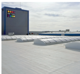
Tipičen primer vgradnje UltraPly™ TPO
