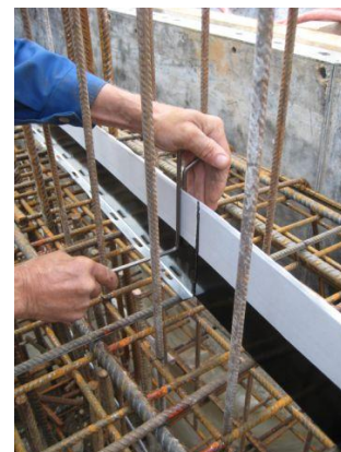
**Z montažno nogo - sidra na 200 cm, v kotih na 20 cm
