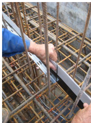
**Z montažno nogo - sidra na 200 cm, v kotih na 20 cm
