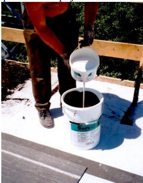
Slika 2, 3: Vlivanje Servidek B komponente v A in mešanje do enotne barve
