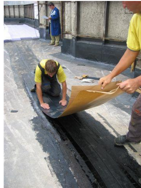
Slika 20, 21: Vgradnja dilatacijskega vložka Serviseal Type B in preko njega Bituthene membrana v širini 50 cm.
