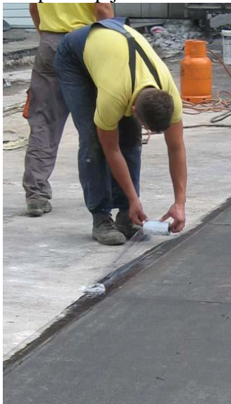
Slika 8, 9: Zaščita dnevnih stikov s polietilensko folijo
