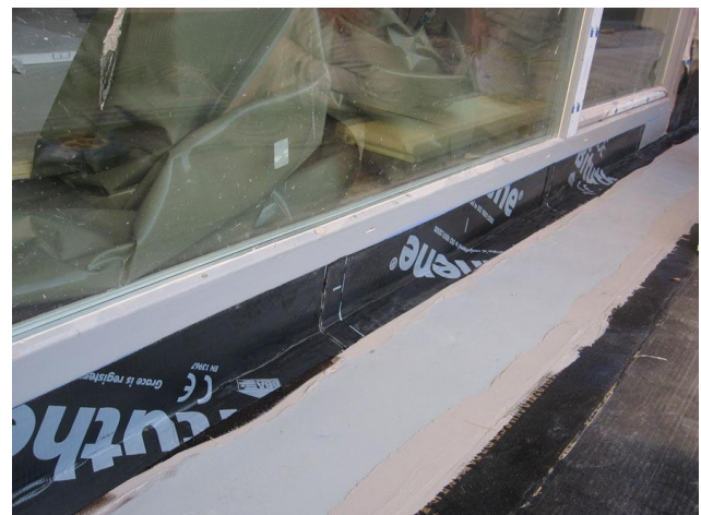
Slika 23: Izvedba dilatacije ob okenjskem okvirju in nadaljevanje s Bituthene 4000
