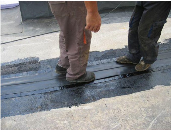
Slika 20, 21: Vgradnja dilatacijskega vložka Serviseal Type B in preko njega Bituthene membrana v širini 50 cm.
