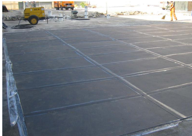
Slika 8, 9: Zaščita dnevnih stikov s polietilensko folijo
