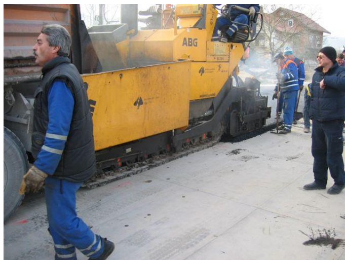
Slika 31: Strojna vgradnja prve plasti asfalta na Servipak plošče
