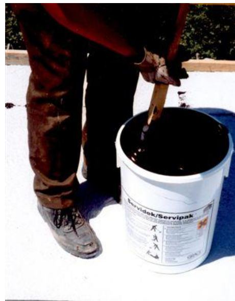
Slika 2, 3: Vlivanje Servidek B komponente v A in mešanje do enotne barve
