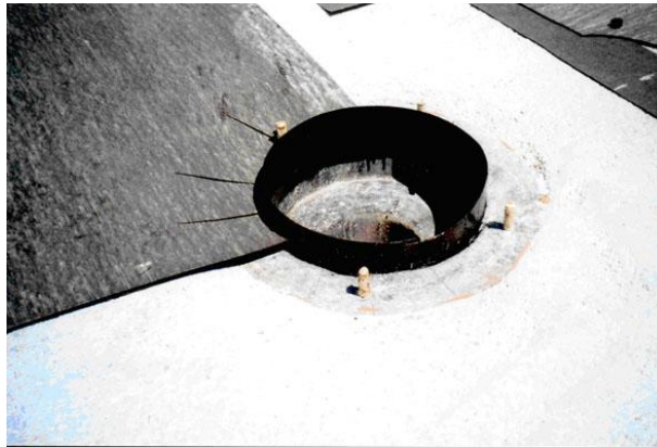
Slika 7: Po meri prikrojena Servipak plošča predeno smo zmešali Servidek komponenti A in B.
