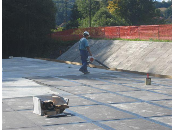
Slika 1: Priprava površine pred vgradnjo Servidek / Servipak-om.
