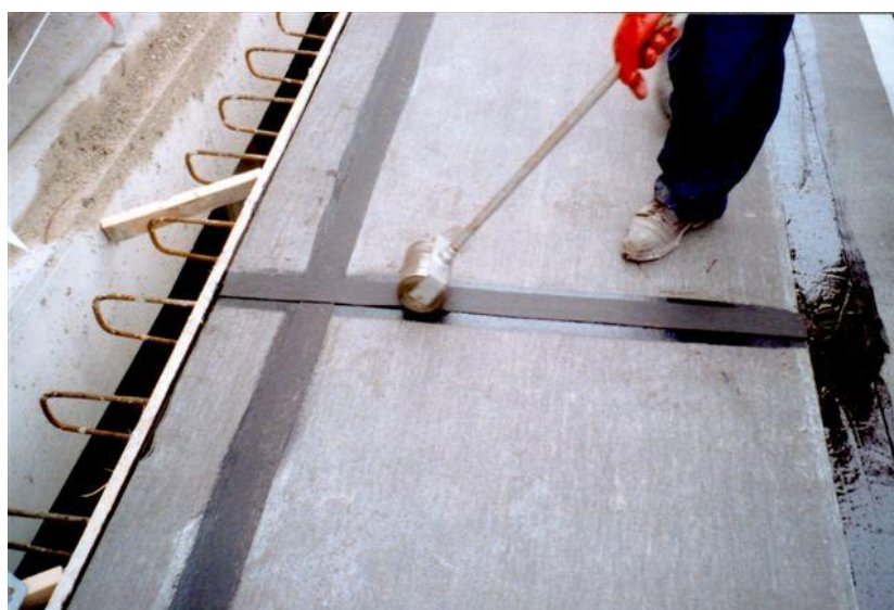
Slika 11: Valčaknje bandažiranih spojev
