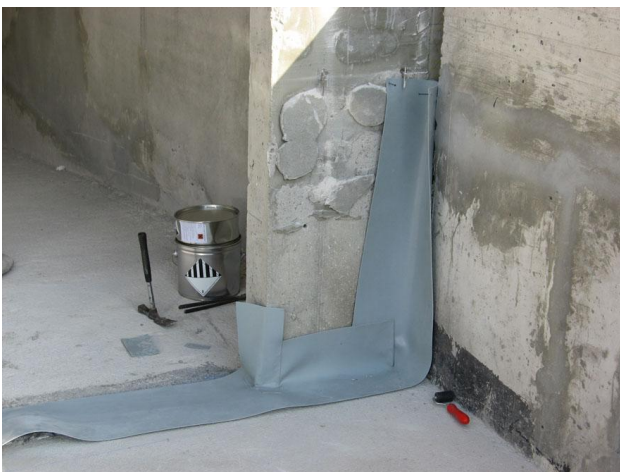
Slika 22: Izdelava nepravilnih oblik na gradbišču
