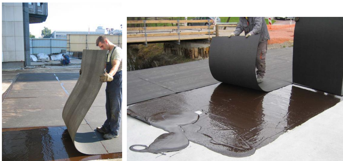
Sliki 5 in 6: Polaganje Servipak zaščitnih plošč v sveži Servidek
