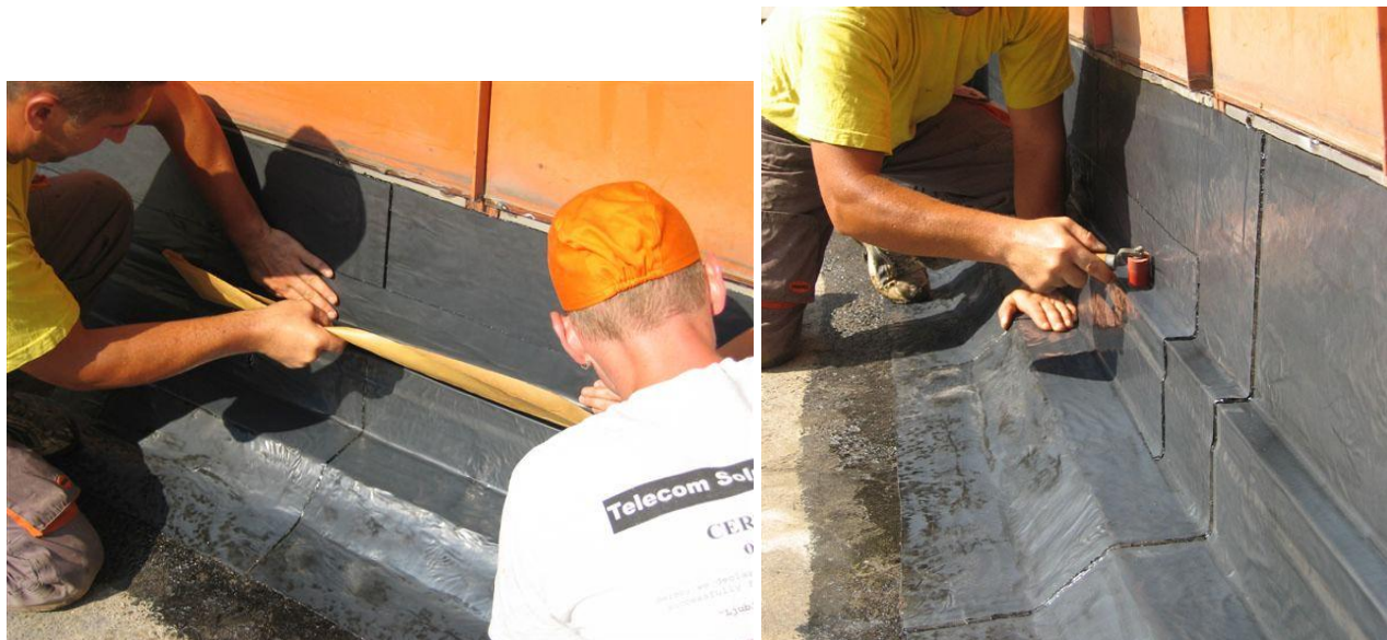
Slika 14, 15: Vgradnja Bituthene membrane na pripravljeno površino in utrjevanje s valjčkanjem
