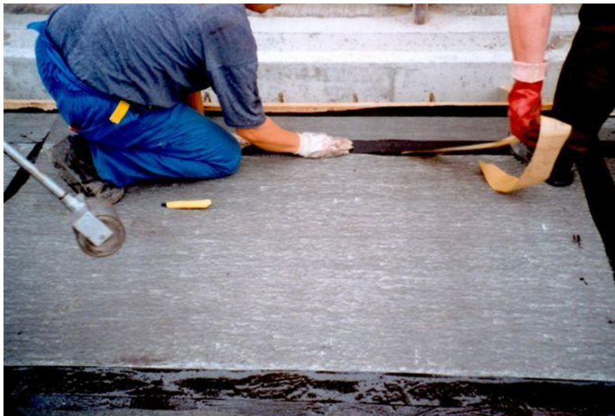
Slika 10: Bandažiranje spojev plošč z Armourtape trakom.
