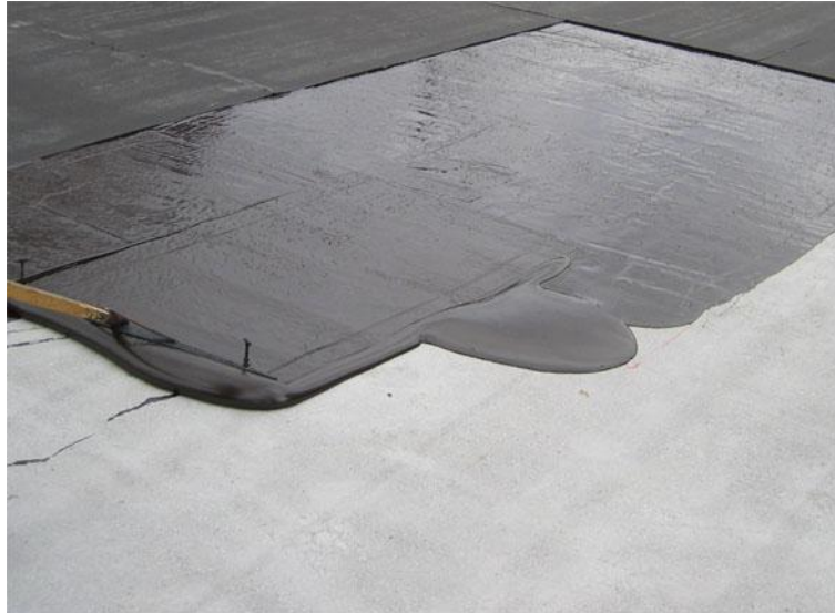
Slika 4: Enakomerno razporejanje Servidek mase
