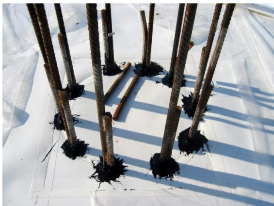
Tesnjenje prebojev armature pilota in že vgrajena armatura direktno na Preprufe 300R
