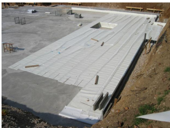
Polaganje Preprufe horizontalne hidroizolacije in odstranjevanje zaščitne folije iz Preprufa 300R pred vgradnjo armature
