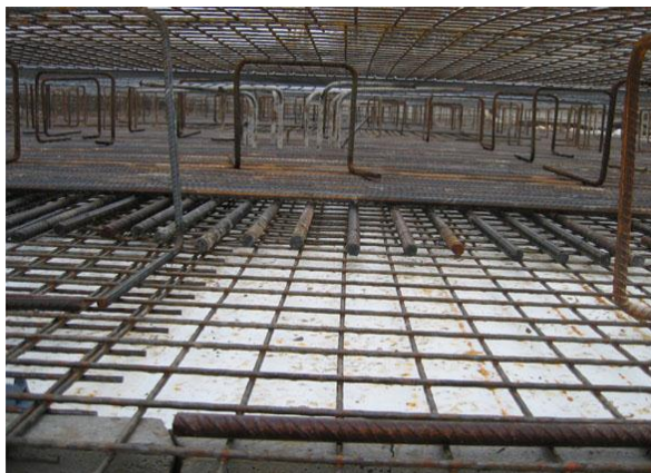
Tesnjenje prebojev armature pilota in že vgrajena armatura direktno na Preprufe 300R
