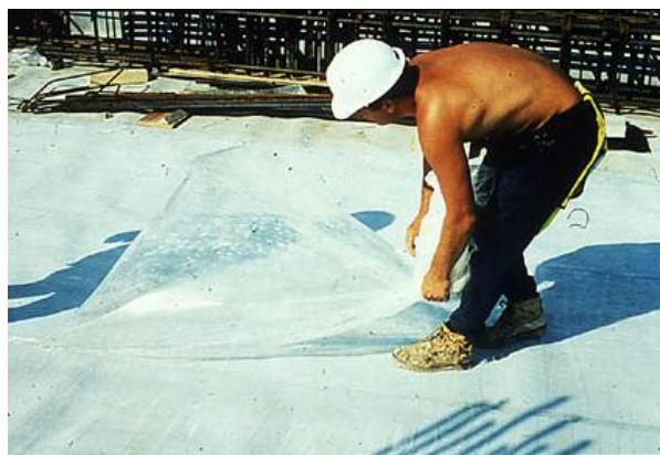
Polaganje Preprufe horizontalne hidroizolacije in odstranjevanje zaščitne folije iz Preprufa 300R pred vgradnjo armature
